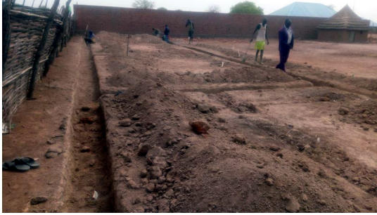
Aushebung für Fundamente von St. Mark Berufsschule
